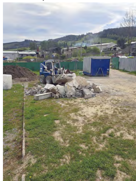
foto: upratovanie starého zberného dvora
