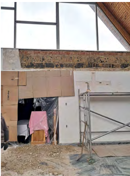
foto: oprava interiéru v dome smútku
