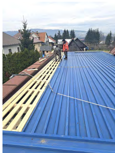
foto: oprava strechy domu smútku
