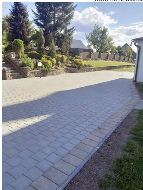
foto: nová dlažba
