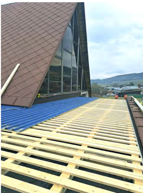
foto: oprava strechy domu smútku
