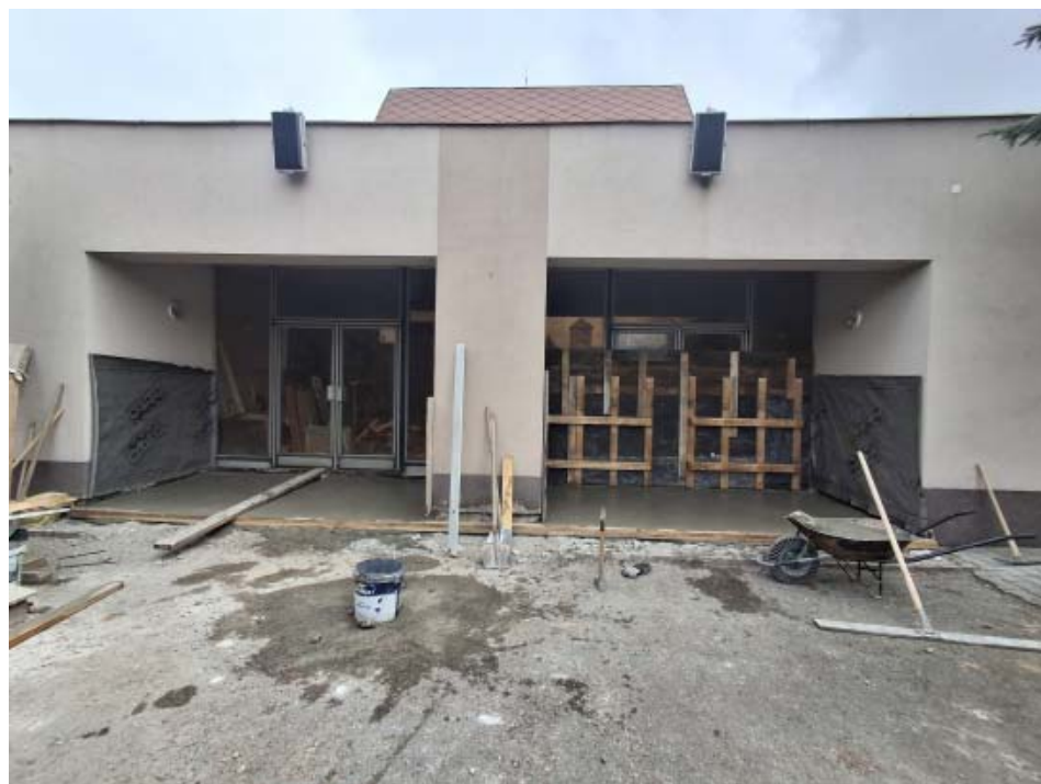
Bezbariérový prístup k Domu smútku
